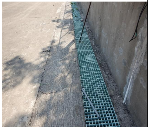
暂存间外的收集沟
