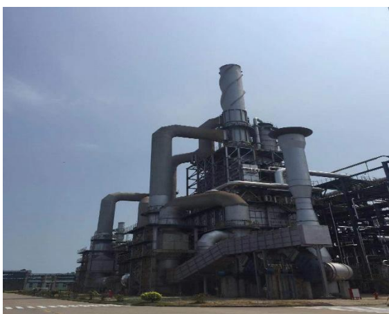
吸附分离装置 2 二甲苯再蒸馏塔重沸炉
