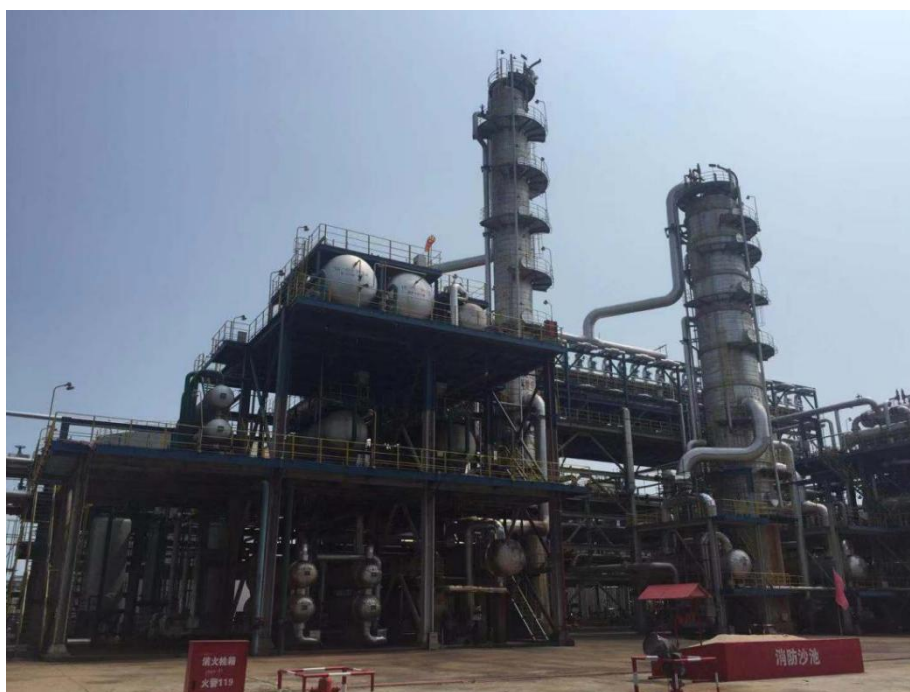
图 4-4 含硫污水汽提装置
