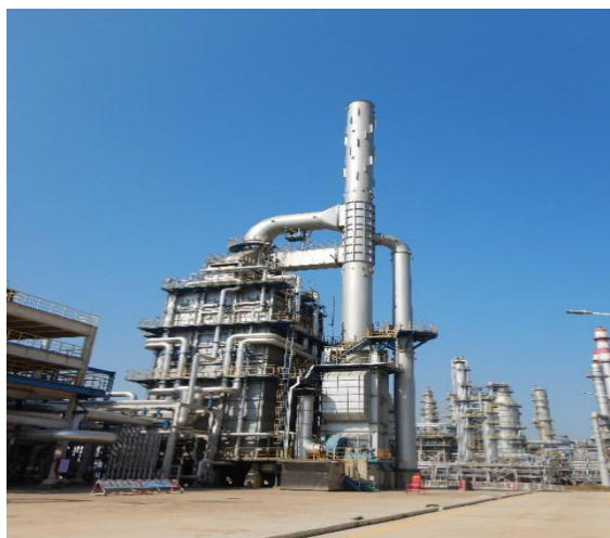
凝析油加氢装置进料加热炉
