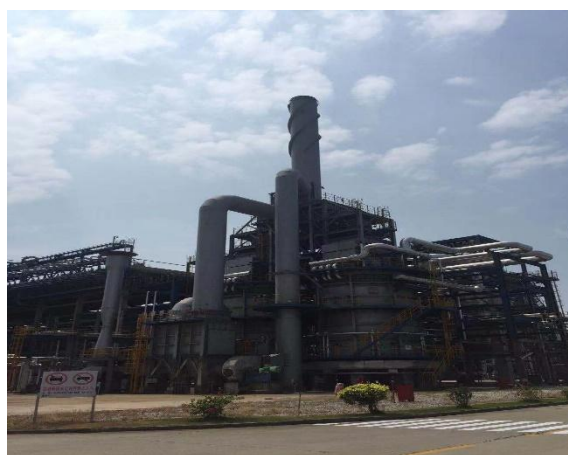
歧化及烷基转移装置反应器进料加热炉
