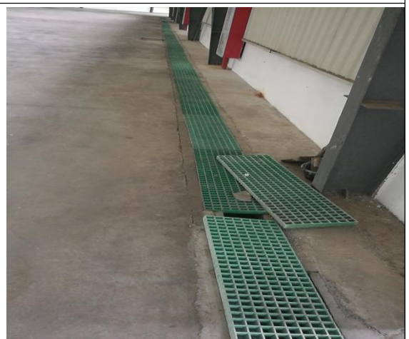
危废暂存间收集沟
