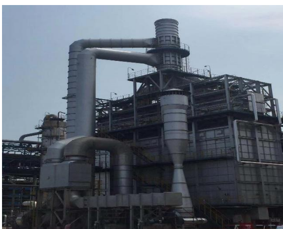
异构化装置 1 反应器进料加热炉
