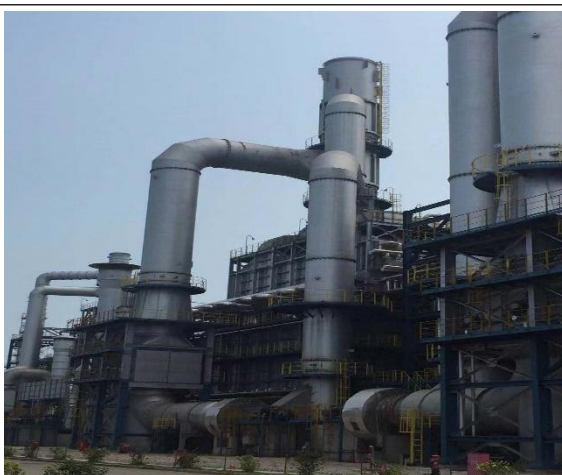
吸附分离装置 1 二甲苯再蒸馏塔重沸炉
