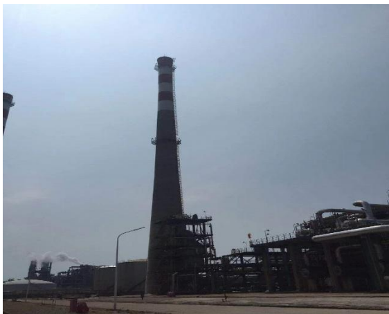
硫磺回收装置尾气焚烧炉
