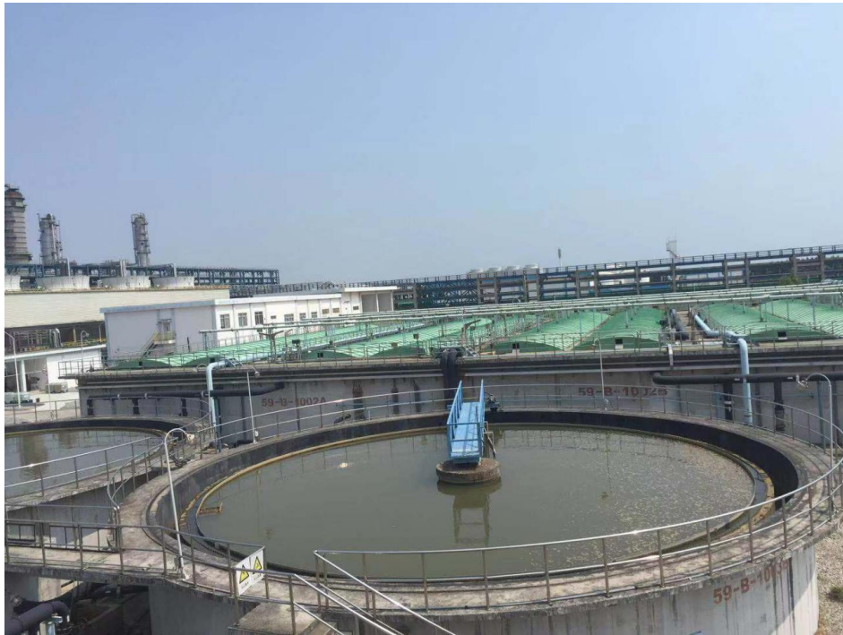
图 4-8 含油污水处理场
