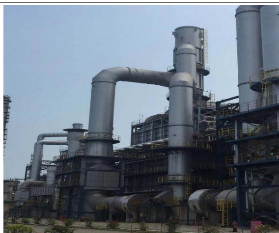
吸附分离装置 1 二甲苯分馏塔重沸炉
