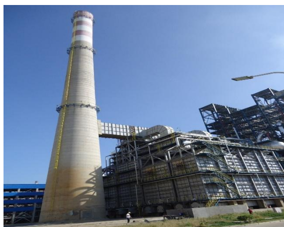
催化重整装置四合一加热炉
